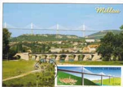
Le viaduc de Millau est un pont à haubans franchissant la vallée de l'Aveyron, dans le département de l'Aveyron, en France. C'est le viaduc de Millau qui prend la relève avec 2 441 m. La structure, qui est en béton, est d'une longueur totale de 2 141,25 mètres elle comporte une travée haubannée de 856 m de portée, les 623 m de cette travée étant en métal. Les pylônes en béton de cette travée atteignent une hauteur de 214,75 m.
